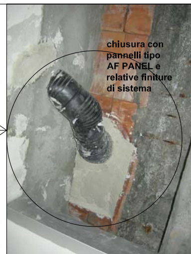
(1): cassonetto in lastre di calcio silicato idrato, nelle dimensioni del sistema certificato (2): mattoni intumescenti a completa sigillatura contro fumi freddi e incendio
