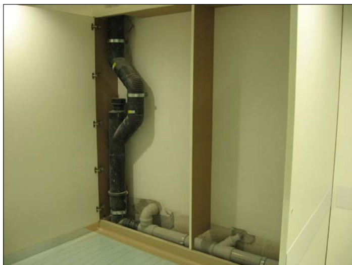
FOTOGRAFIA A: COLONNA ACQUE NERE Ø160 E COLLETTORE AL PIANO LATO DEGENZE
