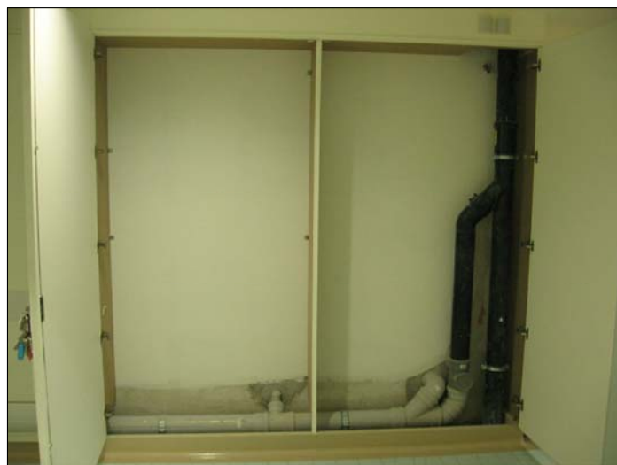
FOTOGRAFIA B: COLONNA VENTILAZIONE Ø110 E RACCORDO CON IL COLLETTORE ACQUE NERE AL PIANO LATO DEGENZE
